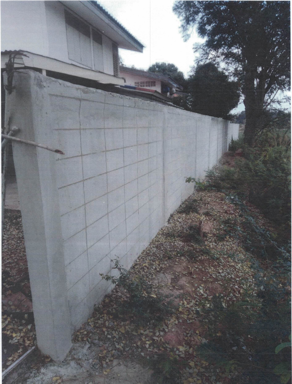
ภาพถ่ายประกอบการก่อสร้างรั้วคอนกรีตบล็อก ขนาดยาว 60 เมตร ณ โรงพยาบาลส่งเสริมสุขภาพตำบลบ้านห้วยยายจิว อ.เทพสถิต จังหวัดชัยภูมิ
